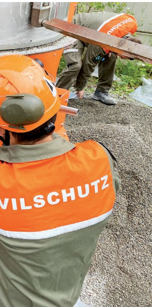
ZIVILSCHUTZ IM EINSATZ: DIE ABFÜLL-ANLAGE FÜR SANDSÄCKE IN GÜTTINGEN. BILD: RFS OBERTHURGAU
